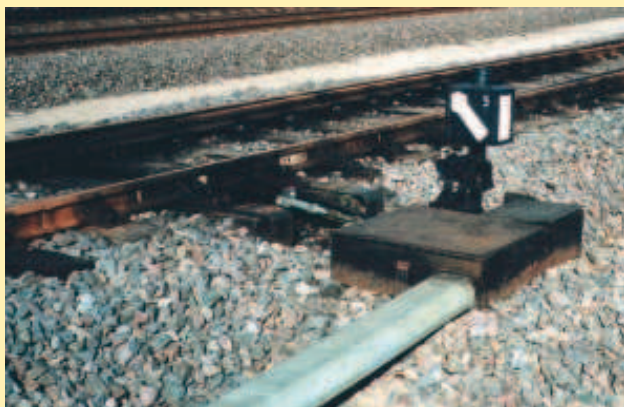
Fot. 3. Zwrotniki w prawdziwych rozjazdach: a) w postaci oświetlonej latarni, z mechanicznym napędem zwrotnicy; b) w postaci blaszanego wskaźnika z przeciwwagą do ręcznego przekładania zwrotnicy.
